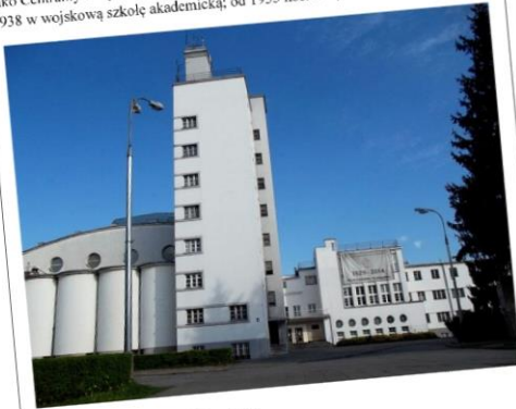
Budynek główny AWF w Warszawie
